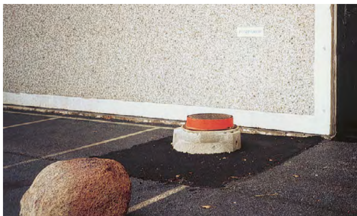
2.136 Vid denna kemiska industri är byggnaden utformad som en stor bas-säng. Golvet ligger en halv meter under marknivån och det finns i förväg iordningställda pumpgropar på utsidan.
