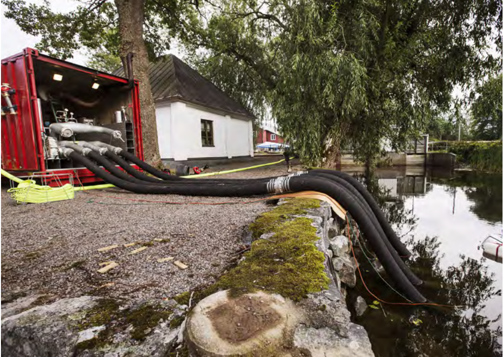
2.132 Angjord pump från MSBs förstärkningsresurs.
