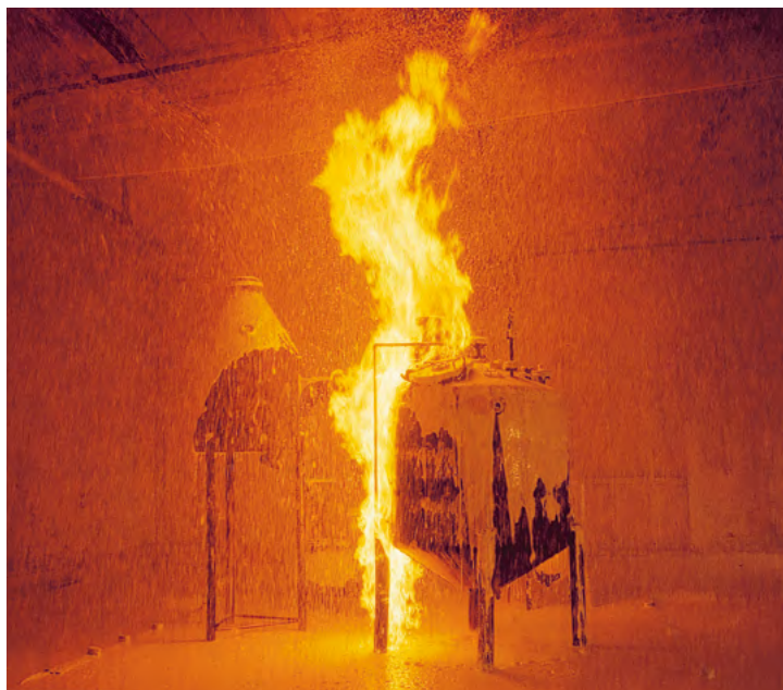
3.28 Skumsprinkler släcker vätskebrand i en industriell process. Vid själva utsläppet krävs ibland en kompletterande manuell insats.
