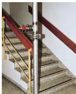
2.46 (ovan samt nedan) Med en stigarledning i höga trapphus är slang- dragningen redan gjord. Inloppet har varselmärk- ning och sitter oftast bakom en låst lucka.
