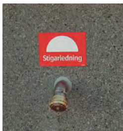
2.46 (ovan samt nedan) Med en stigarledning i höga trapphus är slang- dragningen redan gjord. Inloppet har varselmärk- ning och sitter oftast bakom en låst lucka.
