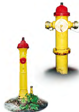
2.9 I Sverige används samma brandposthuvud till alla brandposter. I andra länder, Island exempelvis, används fasta brandposthuvuden med olika storlek beroende på kapaciteten. Då syns om det går att få ut mycket eller lite vatten ur brandposten, vilket inte är möjligt i Sverige.
