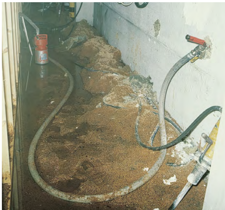
2.122 Genom att borra hål i väggen (bormaskinen står till höger) och sticka in ett applikatorrör minskas värmepåverkan på brandväggen.
