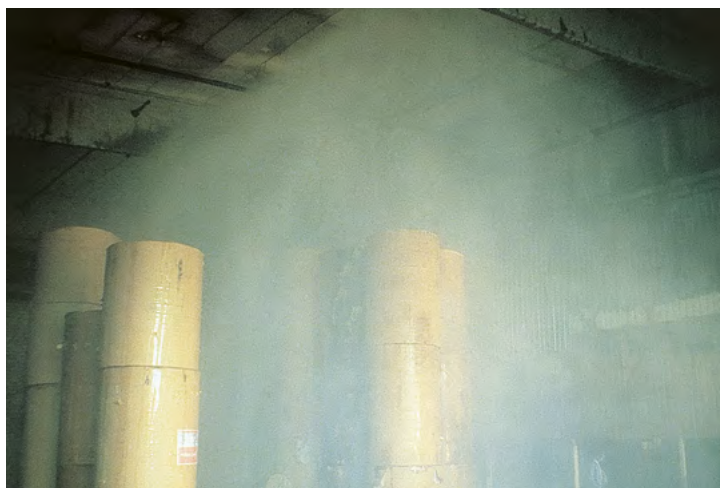
1.8 Med ett fast släcksystem går släckningen ännu bättre, främst på grund av munstyckenas placering ovanför branden.
